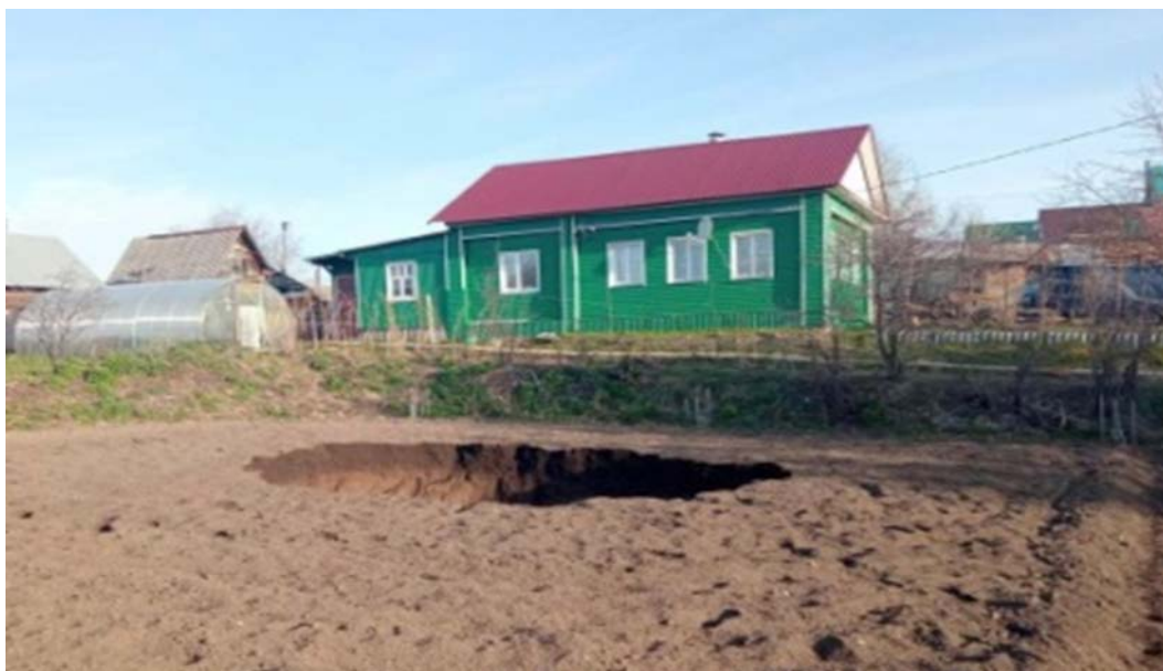
Рисунок 7.4.2.5 – Провал в огороде по ул. Д. Бедного, д.13, г. Благовещенск
